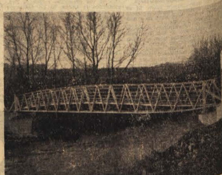
V sodobni tehniški dejavnosti se čedalje bolj uveljavlja aluminij. ki so ga že pred desetletji označili za kovino bodočnosti. Zdaj ga uporabljajo že v številnih industrijskih panogah, gornji posnetek pa kaže most čez angleško reko Ebbw v južnem Walesu; pri gradnji so uporabili izključno aluminijasto konstrukcijo.
