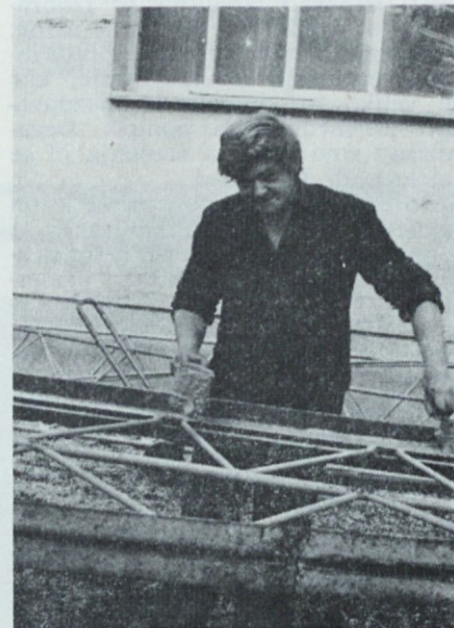
... kot tudi pleskarska dela (na sliki pleskanje konstrukcije za nadstrešek)
