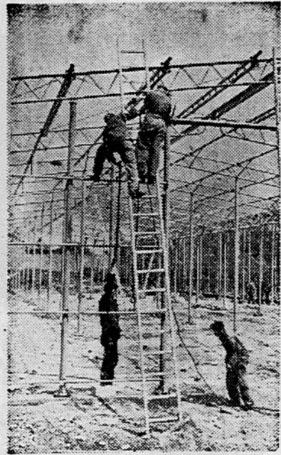
Na gradbišču Gospodarskega razstavišča v Ljubljani: V lesenem opazu mala razstavna dvorana, ki bo imela lupinasto streho; notranjost velike razstavne dvorane v prostorih bivšega podjetja »Mineral«, kjer bo v soboto odprta lovška in ribiška razstava; ogródje tako imenovane montažne dvorane je sestavljeno iz brezšivnih cevi, izdelek železarnice v Sisku.
