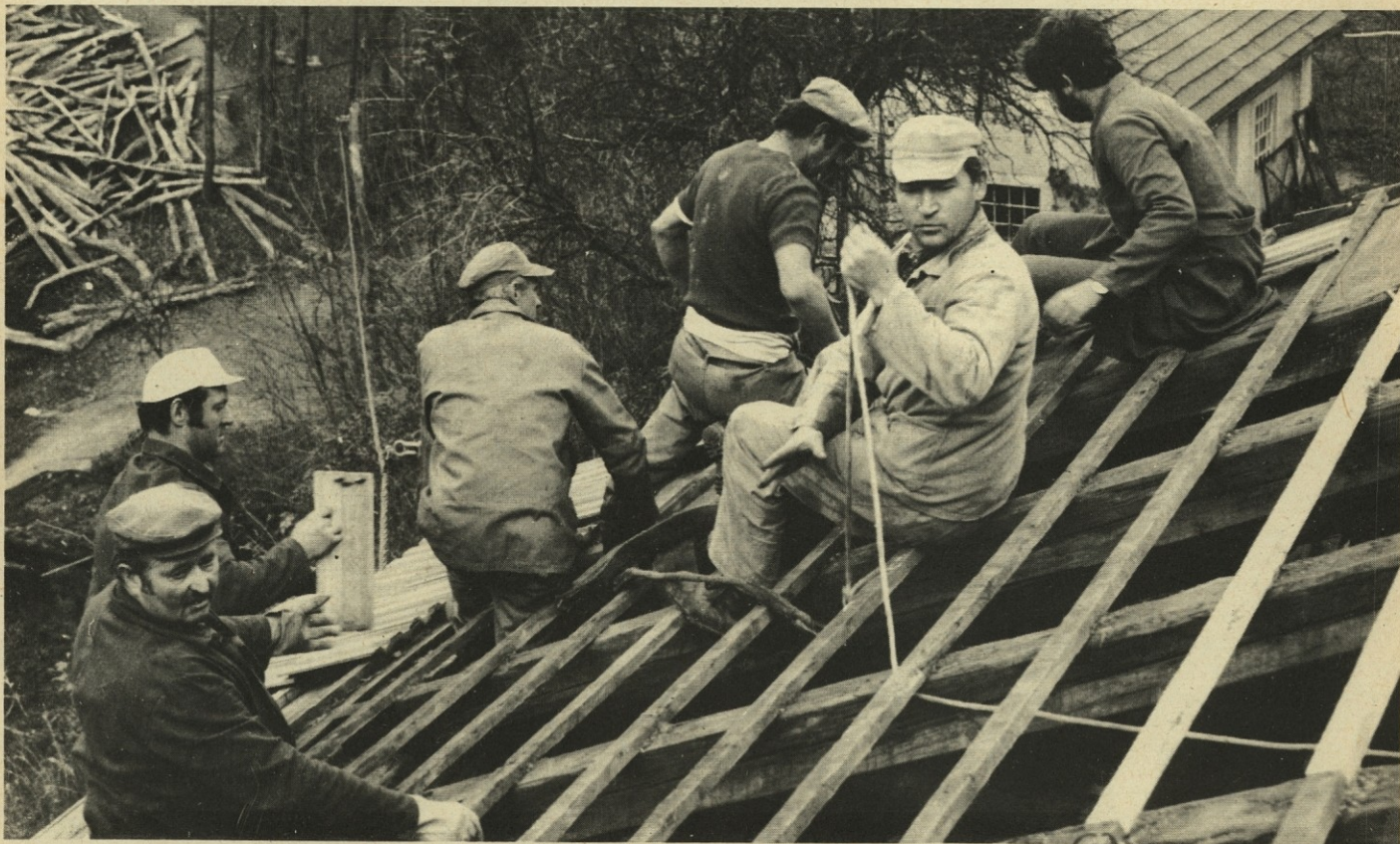
Udarniško prekrivanje strehe bivše obratne zgradbe rudnika Laško, ki so jo namenili za stanovanja. (foto: A. Ogrinec)
