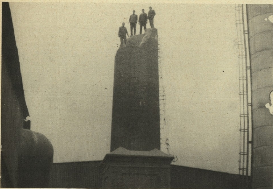
Ko je bil zgrajen nov železo-betonski dimnik na Opekarni, predvsem za potrebe Toplarne, so delavci OGRO Crnotravac iz Beograda pričeli rušiti star opekarniški dimnik na Opekarni v Trbovljah. Spodnji del dimnika bodo ohranili za „spomin“. (foto: B. Bregant)
