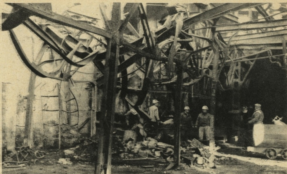
1. decembra 1984 je v poznih večernih urah izbruhnil požar v delavnicah rudnika Hrastnik. Iz fotografije je razvidno pogorišče delavnice, bivše separacije premoga in skupino, ki je pričela s saniranjem. (foto: A. Bregant)
