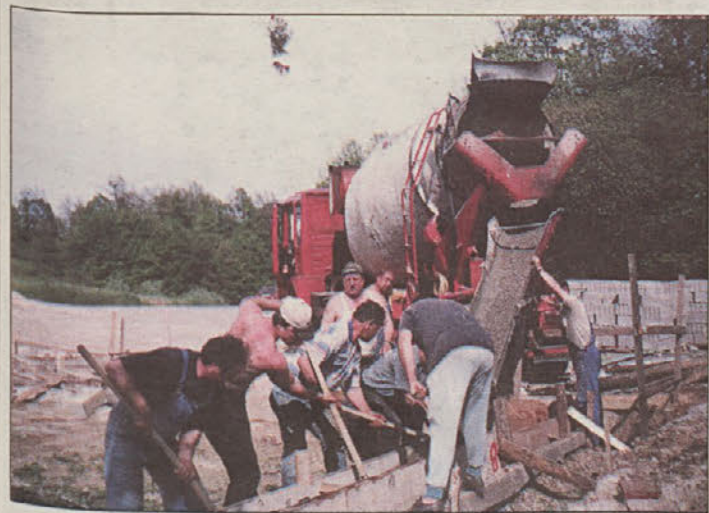
Krajanov pri betoniranju temeljev
