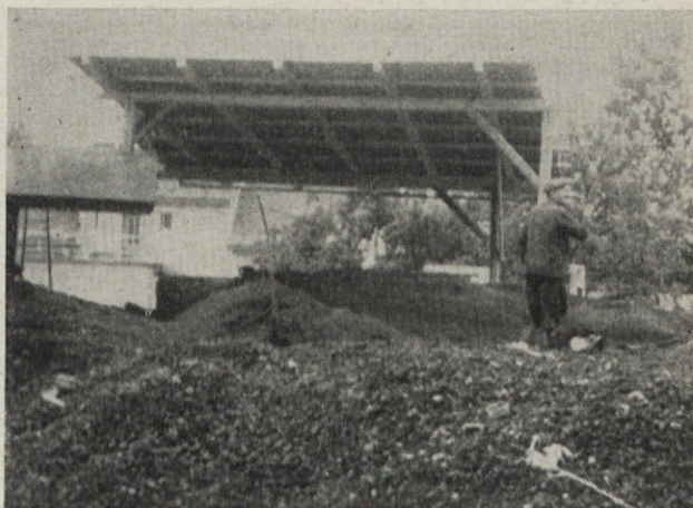
Improvizirana streha nad deponijo za premog
