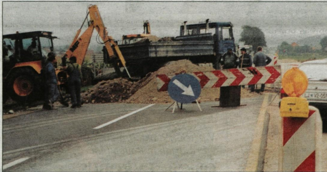
Čeprav je konec septembra že mimo, obvoznica mimo Tosame do avtoceste še ni dokončana, glede na potek dela pa zaključek resnično lahko pričakujemo v kratkem. Takole so se izvajalci lotili ureditve izvoza in uvoza z glavne ceste Ljubljana-Maribor.
