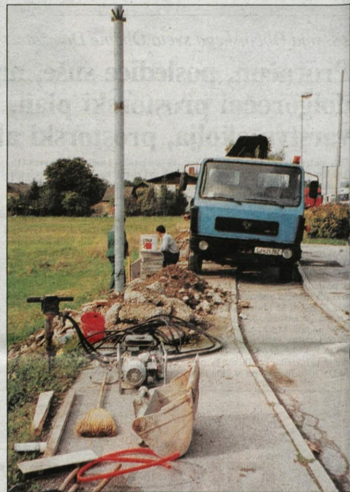
Potem, ko je bila zamenjana ena od avtobusnih postaj v centru Domžal, so v mesecu septembru pričeli z zamenjavo ostalih nadstreškov na avtobusnih postajah ob glavni cesti in regionalni cesti Domžale-Kamnik. Tako bo nova nadstrešek dobila tudi avtobusna postaja na Viru.
