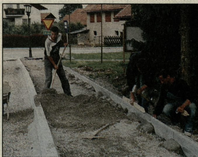
Pri gradnji pločnika
