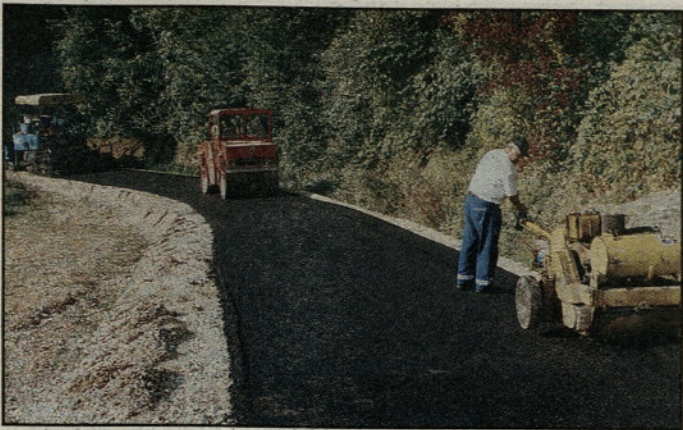
Delavci pri asfaltiranju ceste do Kopanka
