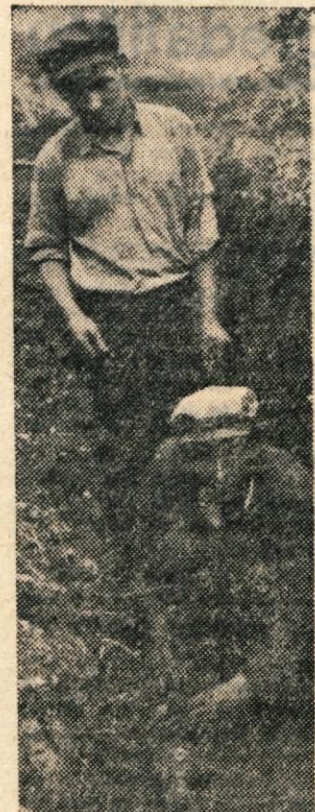
V jarku za novi vodovod proti Lokvici preizkušajo cevi, preden jih spojijo. Delo mora biti natančno in vestno opravljeno, saj gre za zdravje ljudi in za dragoceni material.
