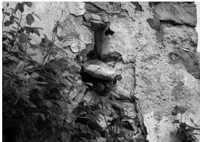
Odvodnjavanje zaprtega balkona. Foto: Mojca Tercej Otorepec, Lisjaki, 15. 5. 2010
