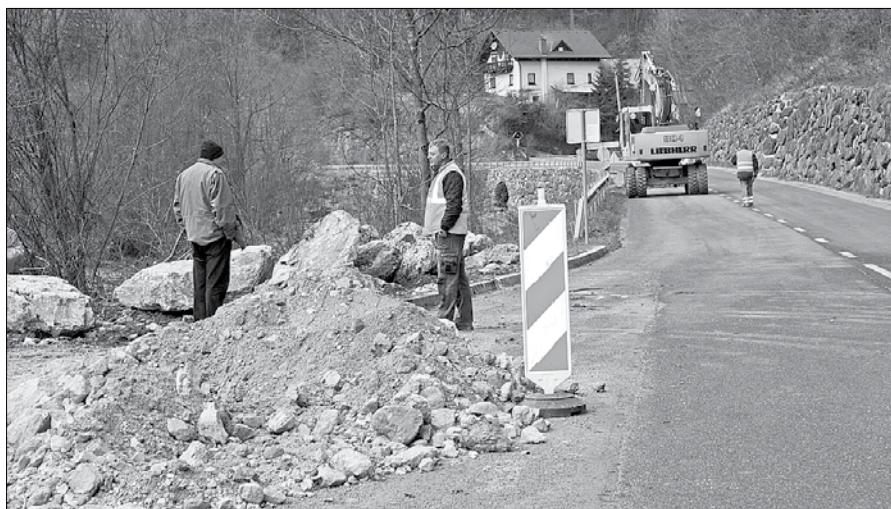
Podjetje VOC Celje izvaja sanacijo na cesti Ljubno-Luč. (Foto: Marija Lebar)
