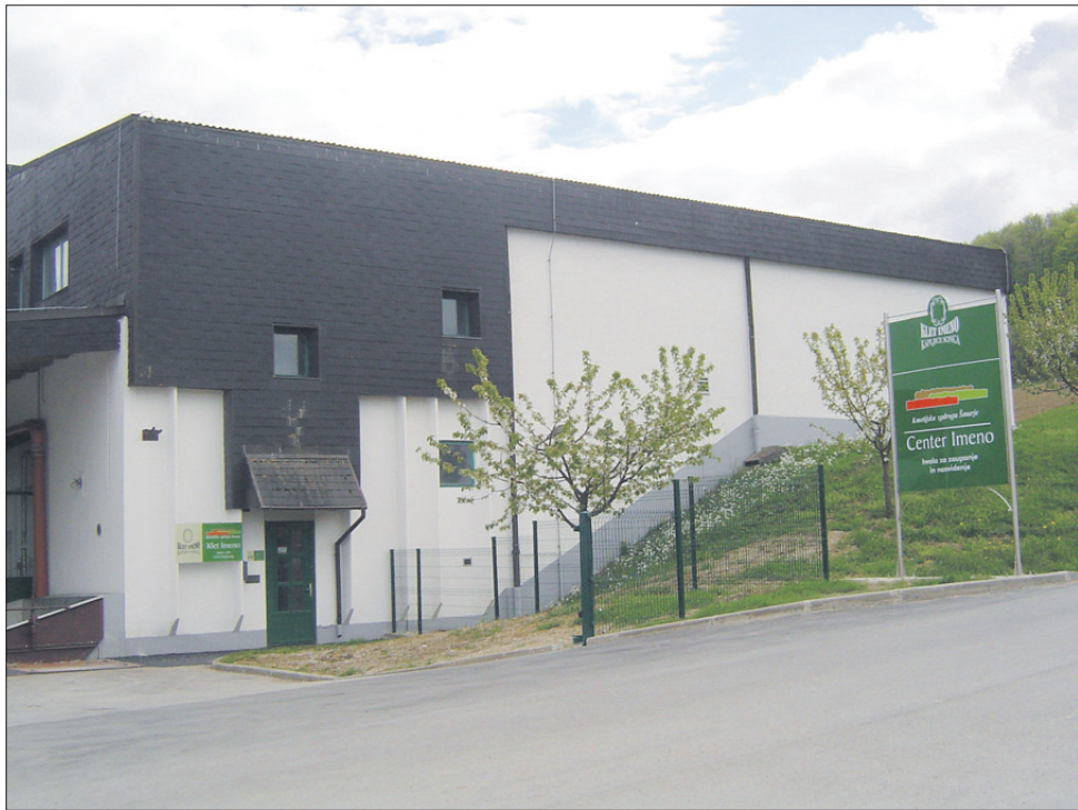
Klet Imeno bo v treh letih celovito obnovljena.
