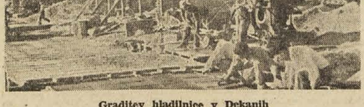
Graditev hladilnice v Dekanjih
