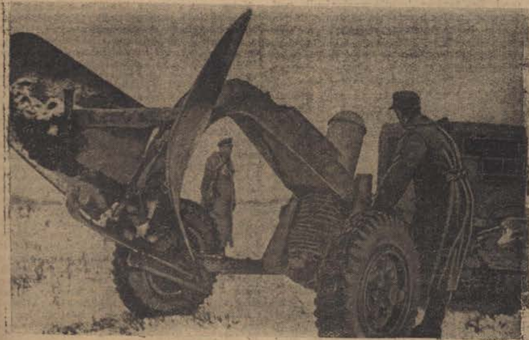
Grabenpflug für den Steilungsbau.
