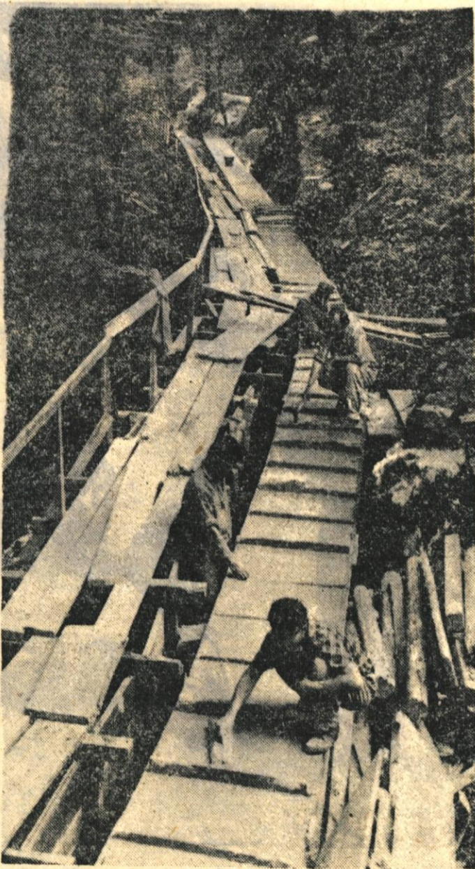
Del rekonstrukcije tržičke tovarne lepence. Voda je doslej tekla po dotrajanem lesenem koritu, v kratkem pa bo po novem betonskem kanalu.
