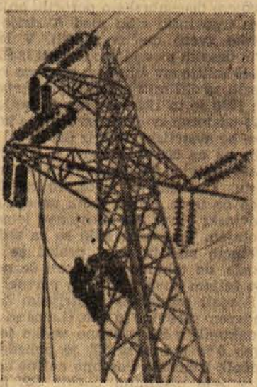
Napeljevanje žice na novem elektrovodu Divača—Hrpelje
