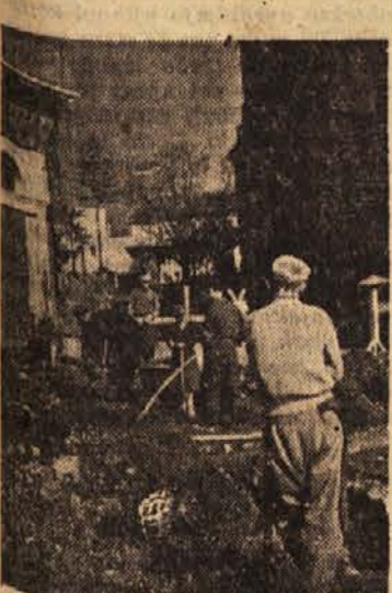
Središče Ptuja ima te dni nenavadno podobo. Delavci, ki polagajo vodovodne cevi, so prispeli na Trg mladinskih brigad. Tudi najbolj žmogledi Ptužjani so zdaj prepričani, da bo mesto končno le dobilo vodovod. Prizor na sliki kaže dela pri polaganju vodovodnih cevi na Trgu mladinskih brigad. Ker pa delo zelo naloži poteka, je zdaj na tem mestu že zopet tlak, jarke pa kopljejo vzdolž Lackove ulice. Do zime nameravajo položiti vodovodne cevi do železniškega prelaza
