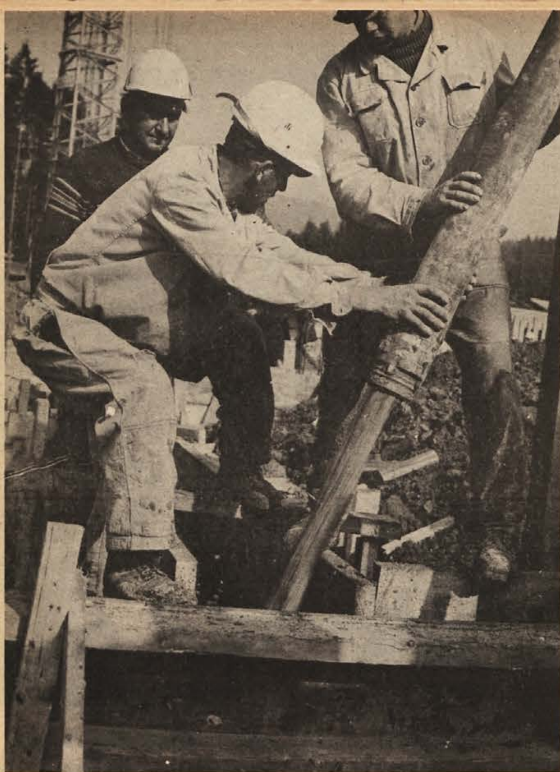
Pionirjevi delavci betonirajo temelje z betonsko črpalko
