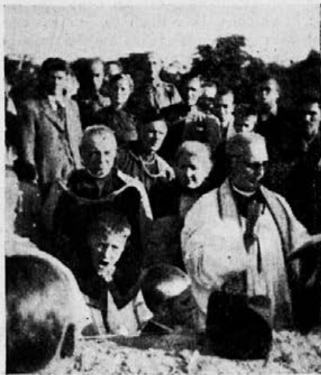
Metliški prošt dr. Stanko Dostal blagoslovlja temeljni kamen
