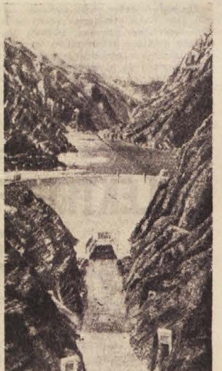
Jez bo visok kot 70-nadstropni nebotičnik, vanj bodo vgradili 12.000.000 ton betona.
