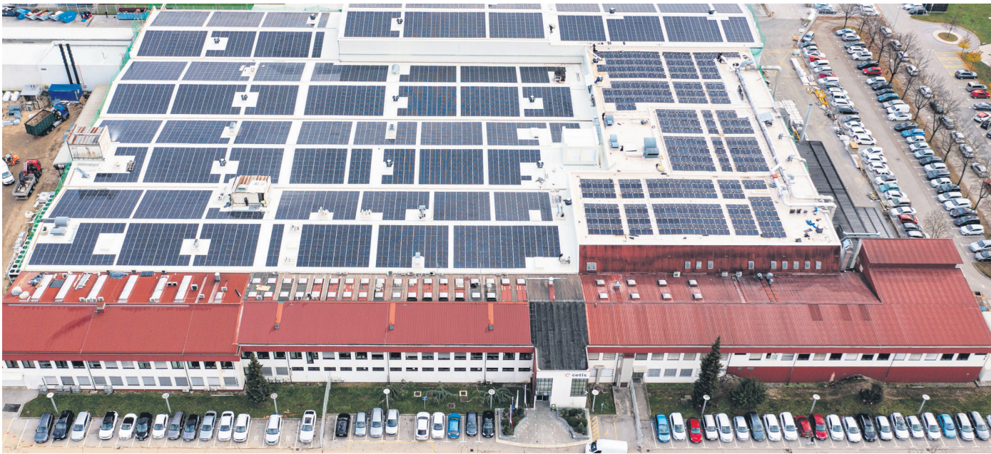
Mnoga podjetja so se v zadnjem času odločila za postavitev sončnih elektrarn na strehah. Takšno potezo je sprejel tudi Cetis, ki moč sonca izkorišča kar na deset tisoč kvadratnih metrih strehe svoje poslovne stavbe. (Foto: arhiv podjetja Cetis)
