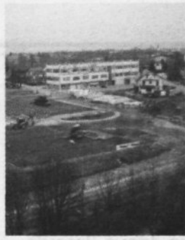
GRADNJA TRGO- VSKEGA KOMPLEKSA NA MAROFU:
