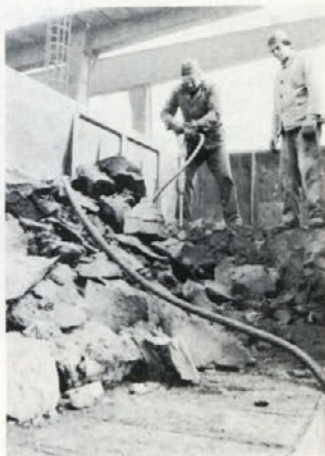
Zmrznjeno rudo je bilo treba obdelovati s krampi in kompresorji
