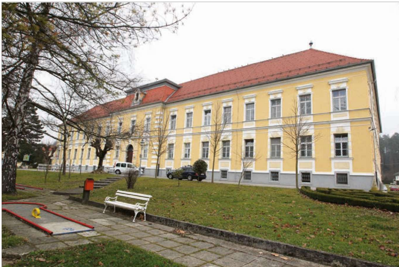
Osrednja stavba vojniške bolnišnice je predlani obeležila zavidljivih 120 let. Pravijo ji stara dama, v zadnjih desetletjih pa se ji je pridružilo še več novih stavb. Zadnja leta jih energetsko prenavljajo. Lani so uspešno končali prvo in drugo fazo, ta mesec bodo uredili še kogeneracijo oz. soprodukcijo toplotne in električne energije. Bolnišnica vsako leto za vzdrževanje objektov in naprav ter naložbe namenja okoli pol milijona evrov.
