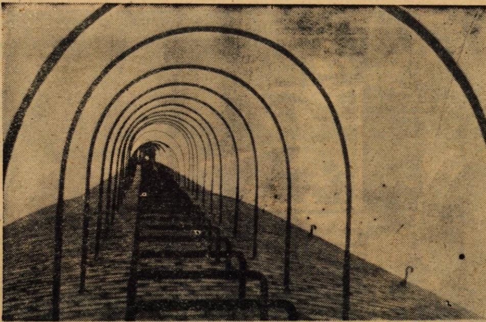
Na ogromen dimnik mora splezati dimnikar 100 metrov visoko. Od spodaj je videti dimnik kot mišja past. Vendar pa plezanje po tem dimniku ni nevarno, ker dimnikarja varujejo posebni loki
