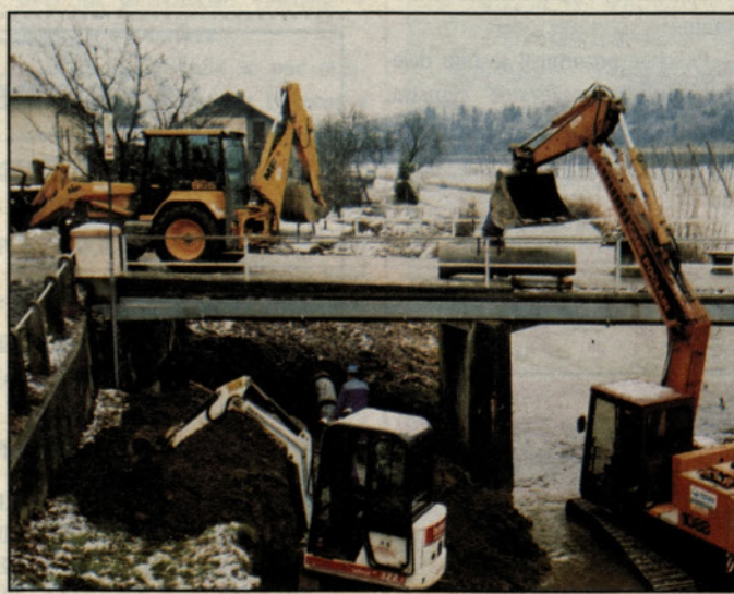
Ugodne vremenske razmere omogočajo izgradnjo kanalizacije tudi v tem času.
