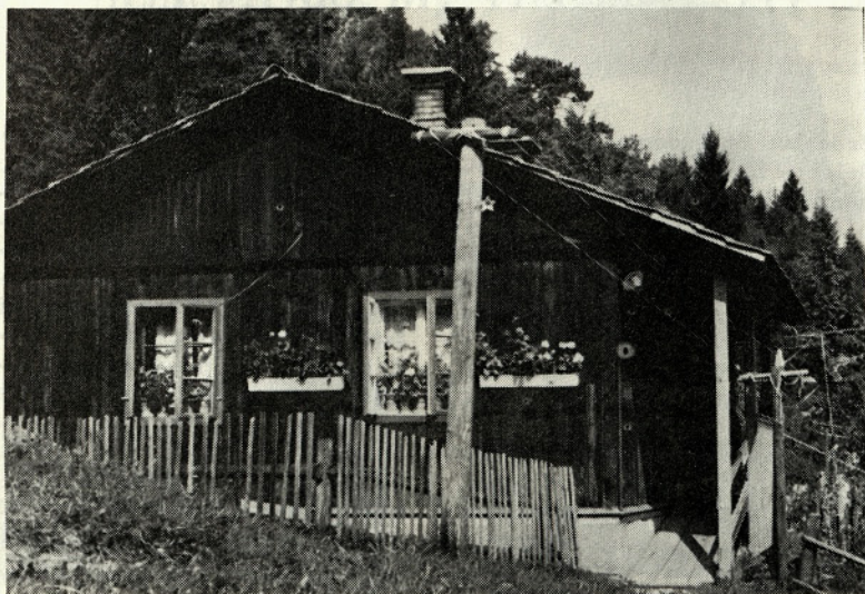
Ena od barak v delavskem naselju naših gradbenih delavcev (v Pasici) - foto GG Bled
