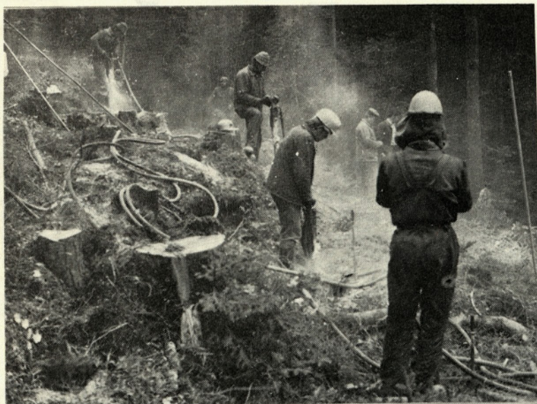
Vrtalci na novi trasi ceste v revirju Martinček (Jelovica) - foto GG Bled
