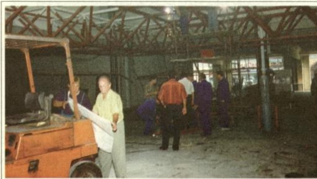
V dvorani E Celjskega sejma urejajo novo kongresno dvorano. Do začetka 30. MOS bo ob zdajšnji Modri dvorani nared še 400 kvadratnih metrov velika mala kongresna dvorana, v njej pa bo že v času letošnjega sejma vrsta srečanj in posvetovanj. V sedmih konferenčnih dvoranah oziroma sejnih sobah bo tako prostora za blizu 1.000 sedežev, največja pa ostaja Modra dvorana s 450 sedeži.
