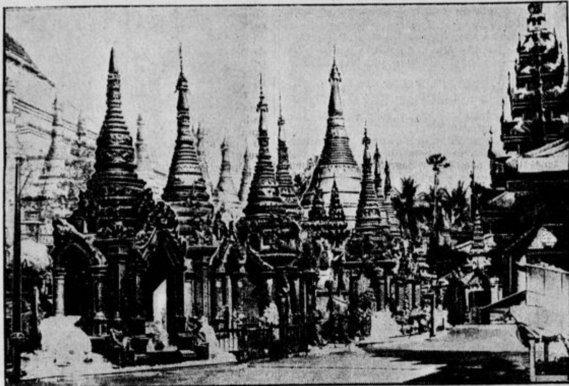
Potresna katastrofa v Zadnji Indiji. Predvor velike pagode Šve-Dagon, eno največjih svetišč na svetu, katero je potres hudo poškodoval. Pagoda je bila sezidana v šestem stoletju, ima streho iz čistega zlata in jo imenujejo sedmo čudo sveta. — Na desni svetišče v Rangoonu, središču strahotnega potresa, ki je zahteval 6000 človeških žrtv.
