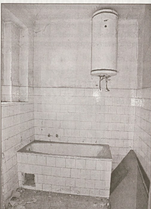
Kopalnica v prvem nadstropju
