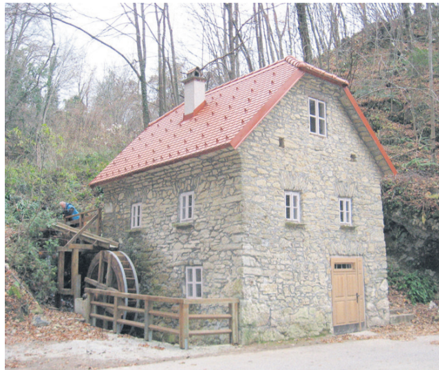
Mlin v Šentjanžu nad Štorami po obnovi
