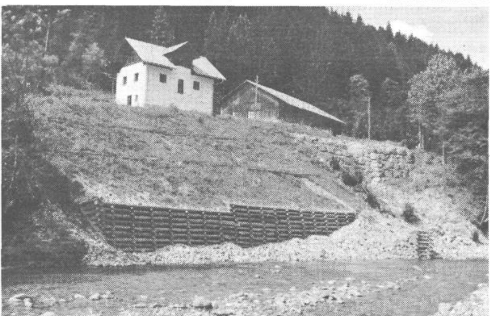
Tudi v hudourništvu uporabljajo v zadnjem času pristope in materiale, ki so bolj prijazni okolju. Tako so n.p. pri Prusnikovi domačiji nad Savinjo uporabili za varovanje brega pred deročo vodo leseno kašto, za zaščito brežine pred površinskim delovanjem vode zatratitev in vrbov poplet, strugo hudourniškega Prusnikovega grabna pa so utrčili s kamnito pregrado iz avtohtonega kamnja. (Foto: S. J.)
