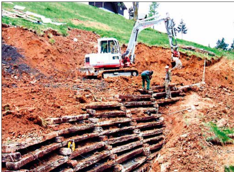
Sanacija zemeljskega plazju na Groharjevi domačiji.
