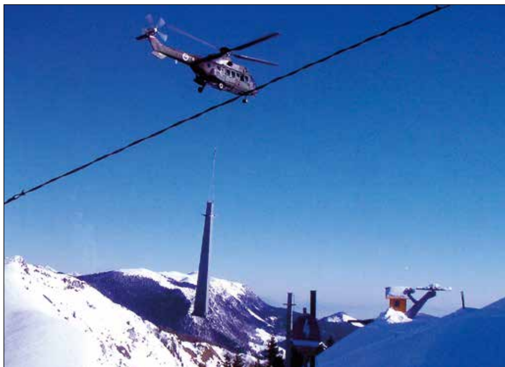
Postavljanje stebrov dvosedežnice.
