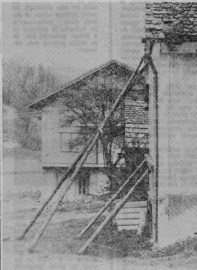
Hiša, podprta s stebri, takoj zraven pa novo poslopje, takšna je danes slika skoraj povsod po Smarskem, ki dovolj zgovorno ilustrira položaj v pokrajini, ki jo je močno prizadel potres pred leti. Stebri bodo smarskim kmetom, ti so bili najhujše prizadeti, kmalu le samo še spomin: večina primerov je rešenih.
