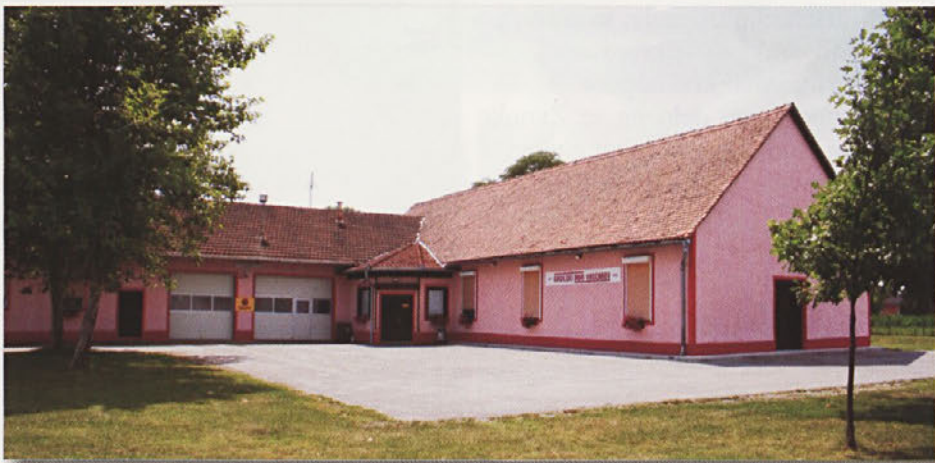
Gasilski dom v Moškanjcih
