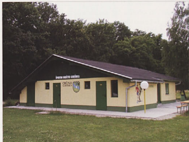
Prostori ŠD Gorišnica narejeni s prostovoljnim delom
