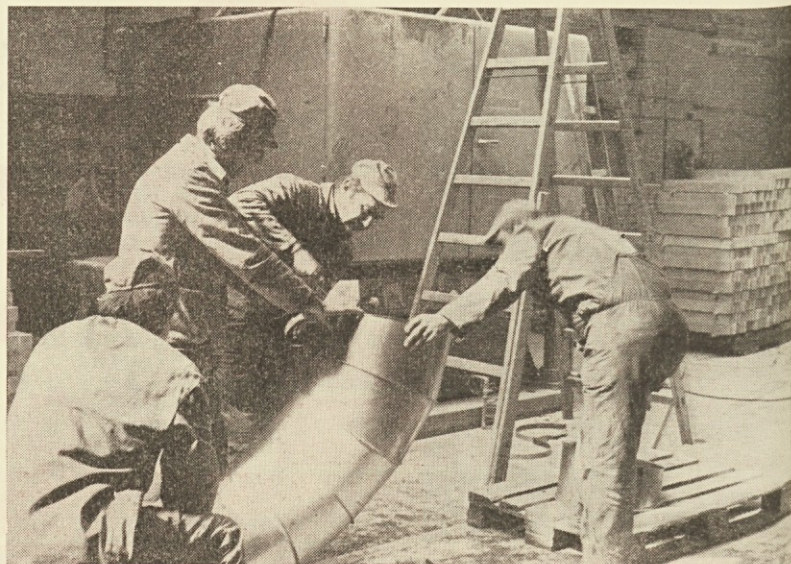
Montaža nove brusilke v TOZD MASIVA; le-ta je iz nove naložbene pošiljke.
