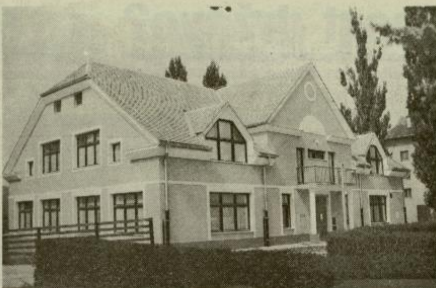
Šola, ki so jo zgradili v Trnavi, bo nadomestila staro v Orli vasi, ki jo bodo, ker je na trasi bodoče avtoceste Arja vas-Vransko, porušili.
