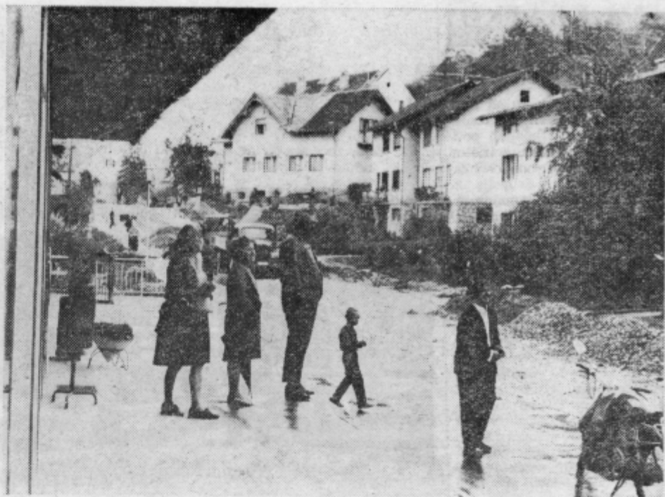
Šentjur je vedno živ; tu obnavljajo, gradijo, popravljajo.
