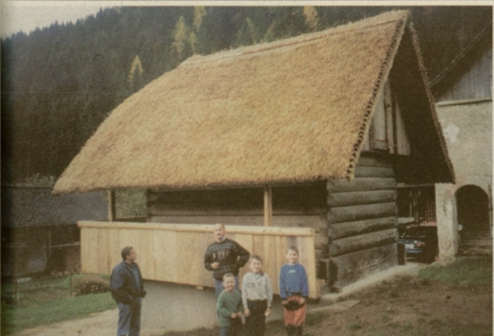
Obnovljena Remšakova kašča s ponosnim gospodarjem in njegovimi tremi »koštruni«.
