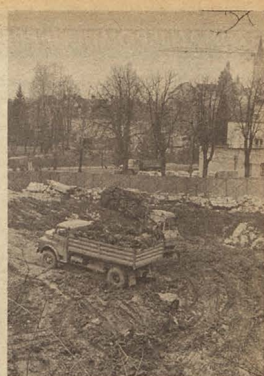
NOVA BANKA – Ob Ljubljanski cesti v Novem mestu (pri Petrolu) so se pričela zemeljska dela za novo štirinadstropno stavbo Ljubljanske banke. Izvajalec del SGP Pionir bo gradbena dela predvidoma končal v oktobru. (Foto: Janez Pavlin)
