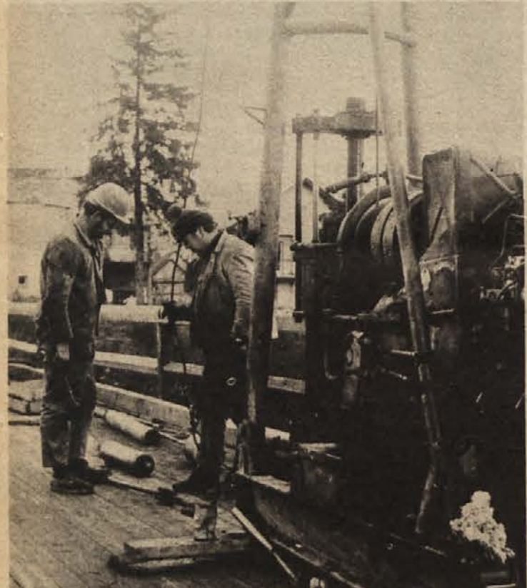
Zavod za raziskavo materiala iz Ljubljane raziskuje sestav in trdnost tal v Krkini strugi v Krški vasi, kjer bodo gradili nov most. Sedanjí leseni je močno zdelan in ga vsak čas popravljajo. Zaslužil si je pokoj. (Foto: Jožica Teppey)
