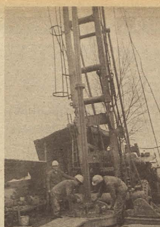
NOVI VRELCI? – V neposredni bližini rastlinjakov Agrarie na Čatežu vrtajo delavci Geološkega zavoda iz Ljubljane novo vrtino do zaloga termalne vode. Vodo potrebuje Agraria za razširitev toplih gred. Vrtalci se nadejajo, da jo bodo našli 380 do 400 m globoko.
