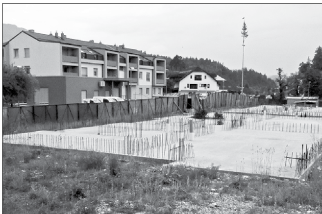
Prvi blok iz omenjenega kompleksa v središču Nazarij je bil zgrajen leta 2012. Takrat so tudi položili instalacije za drugo stavbo in izvedli temeljno ploščo. (Foto: IS)
