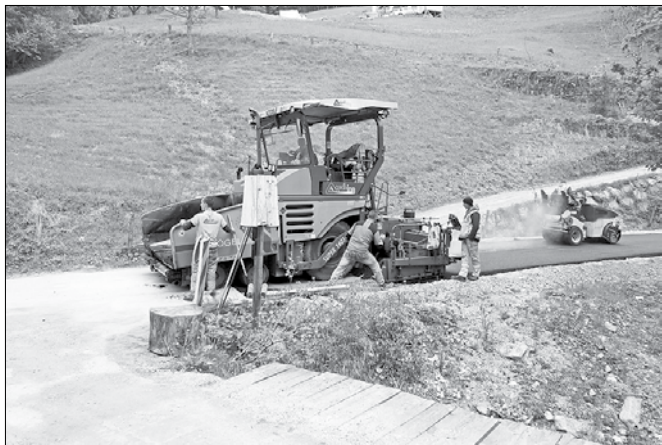
Pretekli petek so z asfaltiranjem zaključili preno-vo ceste v Matkovem kotu. (Fotodokumentacija Občine Solčava)
