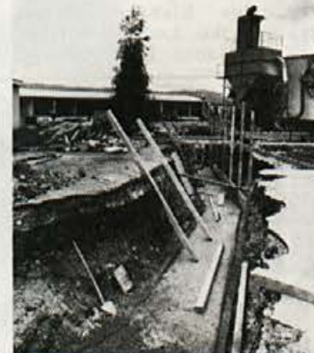
Prestavitev elektroenergetskih kablov.
