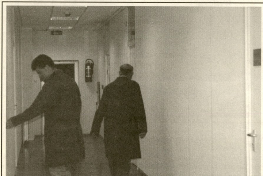
Zadnji kontrolni pregled novih prostorov (ki so vsi s hodnikom vred v sterilno beli barvi) pod budnim inženirskim očesom vodje adaptacijskih del Janezom Dimicem.
