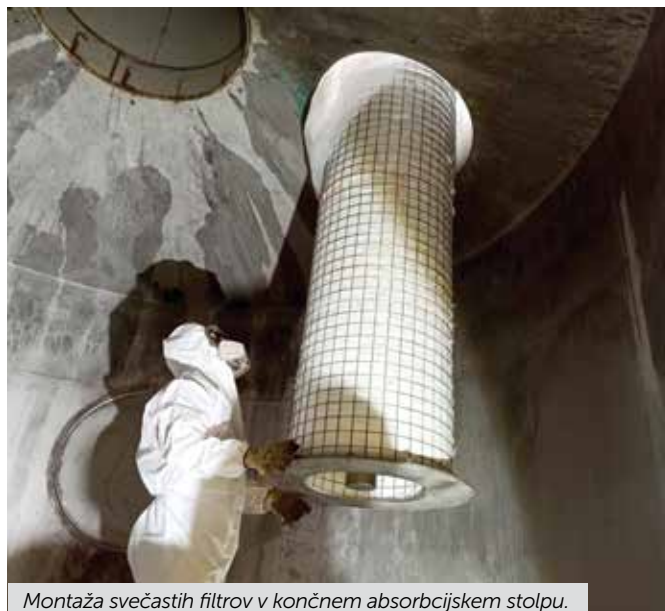
Montaža svečastih filtrov v končnem absorpcijskem stolpu.
