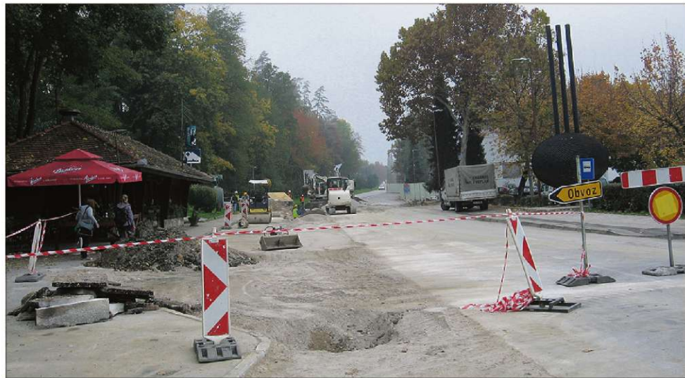
Z gradbišča v Zrečah, kjer gradijo odsek primarne kanalizacije. V teh dneh se bo začela še gradnja čistilne naprave.
