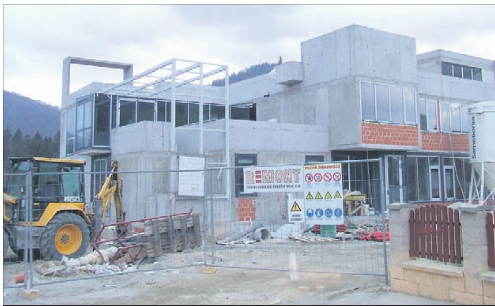
V teh dneh delavci Remonta pospešeno urejajo notranjost novega mozirskega varstveno delovnega centra z bivalno enoto.
