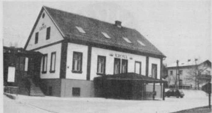
Novi poslovni objekt Krona na Potrčevi v Ptujju.
