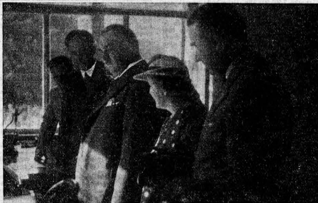
Predsednik vlade si z gospo soprogo ogleduje naprave v avtomatski telefonski centrali na Bledu
