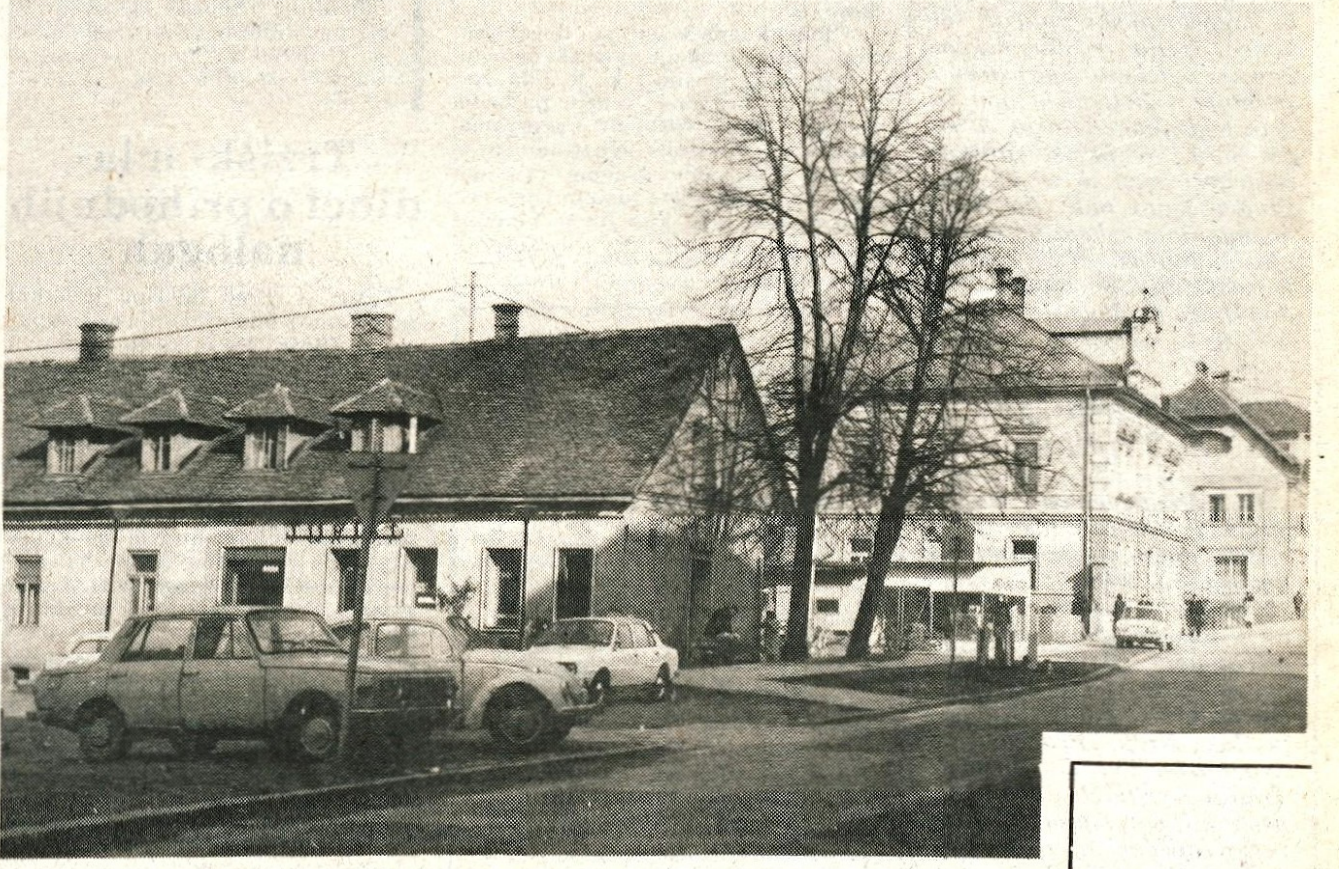
Finkova hiša dan pred rušenjem — Finkova hiša v Kranju in bližnja poslopja na nekdanjem Bekselnu so že pripravljena za rušenje. Okolica je že primerno zavarovana, prav tako pa so pripravljala dela že opravili mineri. Mine bodo predvidoma aktivirane jutri ob 16. uri, ko se bo Finkova hiša sesedla. Na tem mestu bo zgrajeno novo poslopje banke (jk) — Foto: F. Perdan
