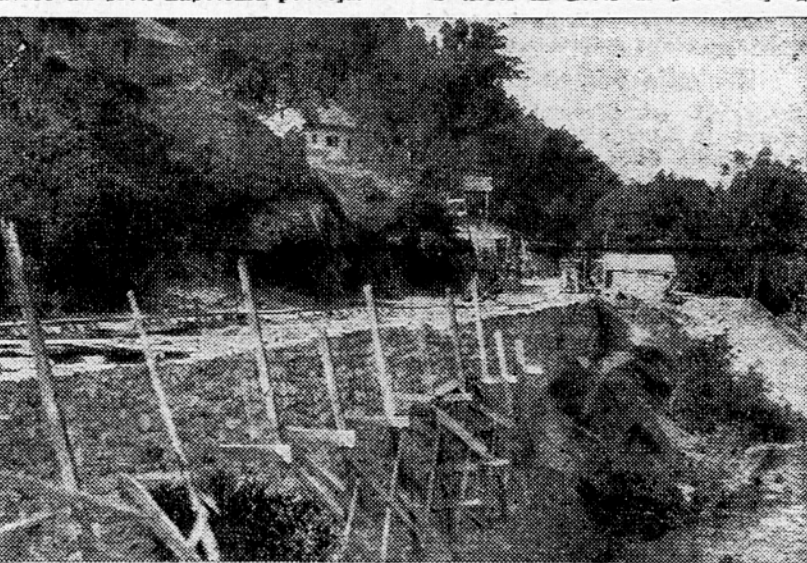
Del spodnjega opornega zidu ob reki Bistrici, nad katerim bo tekla nova cesta
