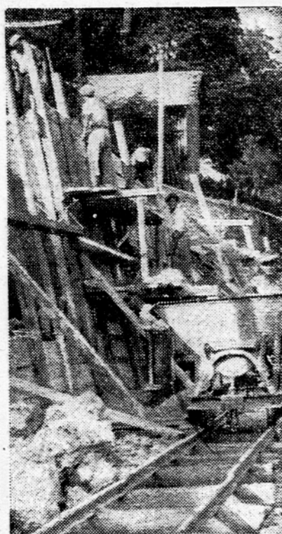
Delavci postavljajo zgornji oporni zid, ki bo varoval cesto in utrjeval pobočje, na katerem bodo zgrajeni trije stanovanjski bloki
