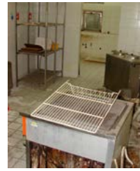
Jedilnica v Jeklarni med preureditvijo in obnovo
